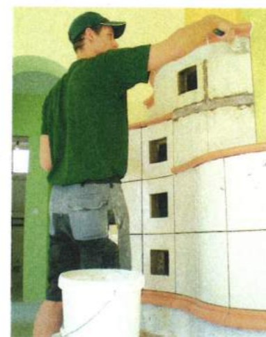
Die Funktionsweise eines Kachelofens (re.). Jeder Ofen wird in Handarbeit gemauert
