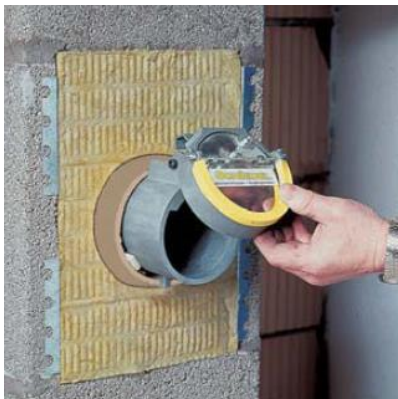
Abbildung 9: Einbaubeispiel Explosionsklappe (Quelle:
